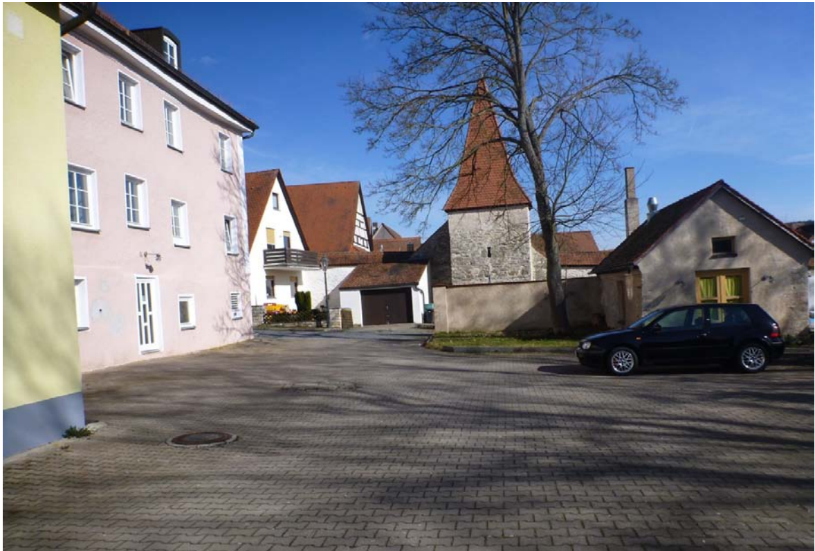
Abb. 7: Blick nach Osten von Park- und Hoffläche auf die Stadtmauer
