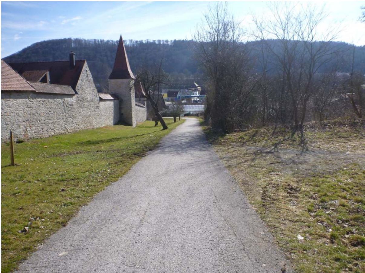
Abb. 11: Blick nach Südwesten auf den Fußweg entlang der Stadtmauer
